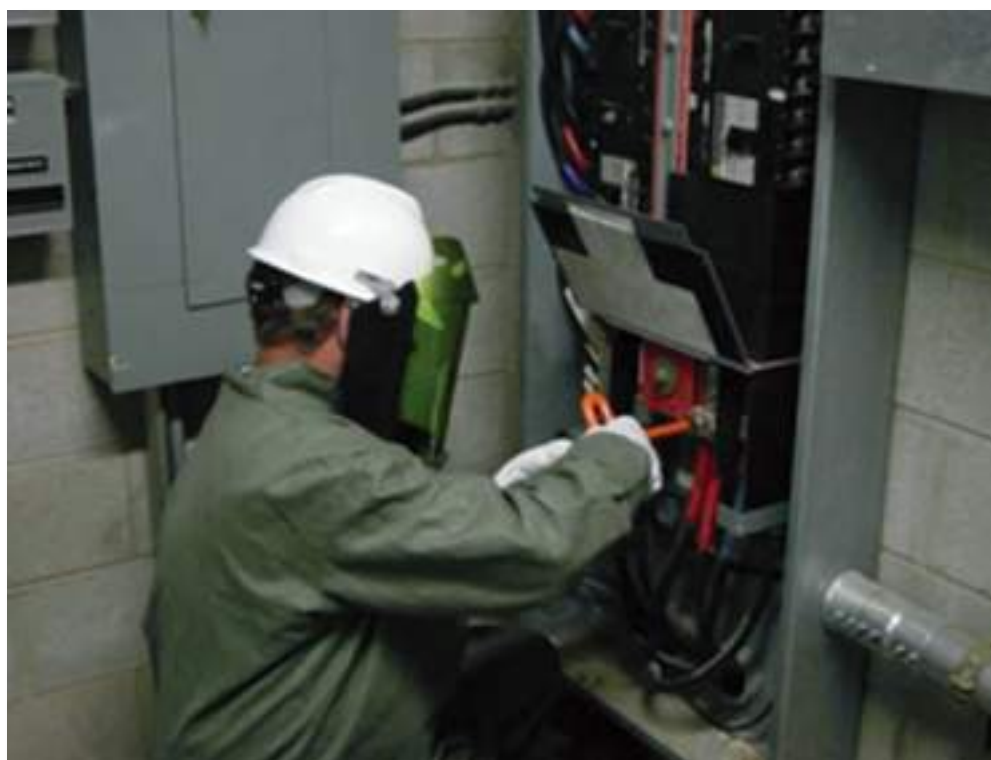
Fig. 6 – Trabalho em eletricidade (baixa tensão)
