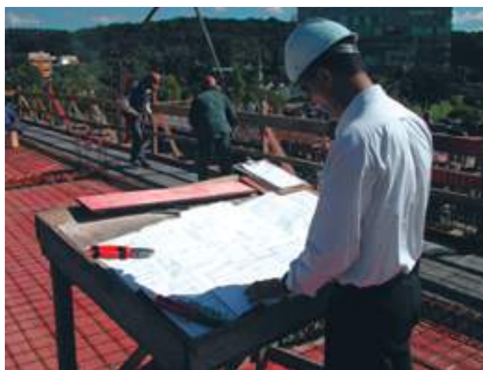
Fig. 5 – Engenheiro em acompanhamento de obra
