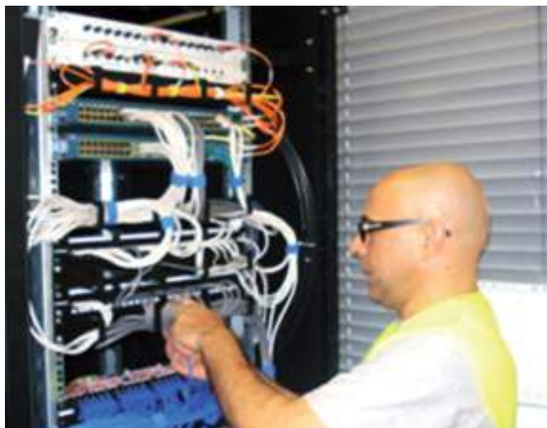
Fig. 8 – Técnico a trabalhar em sistemas de telecomunicações
