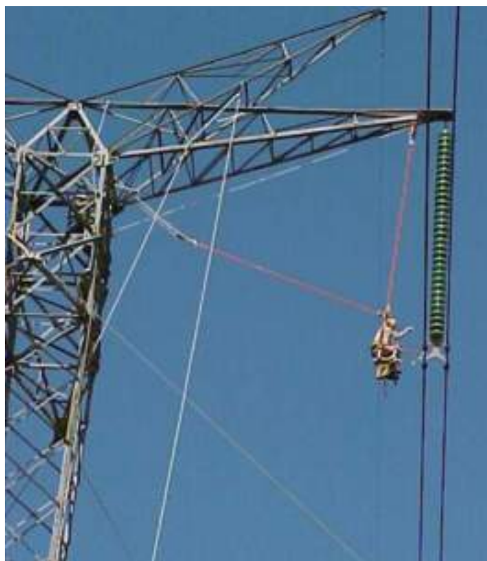
Fig. 5 – Isolador em linha de transporte de energia
